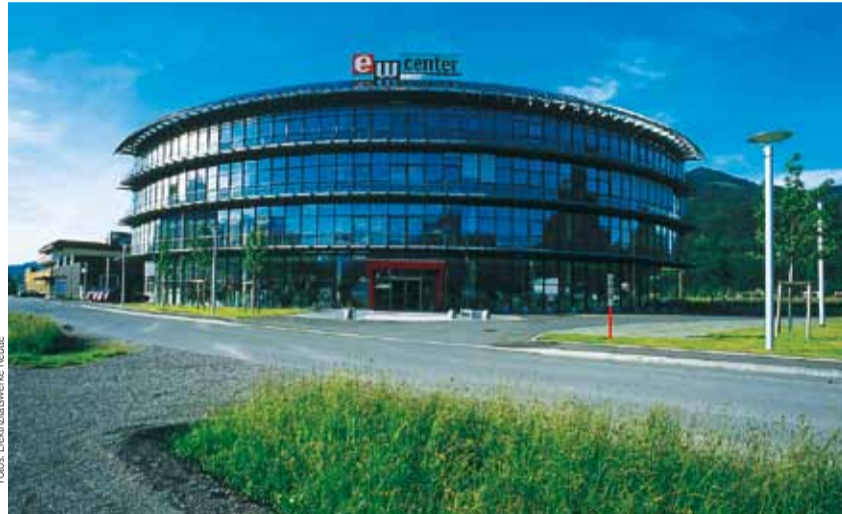
Für die Elektrizitätswerke Reutte ist der Einsatz der Brennstoffzellen-Technologie eine gute Möglichkeit, ihren Kunden einen besonderen Mehrwert bieten zu können.
